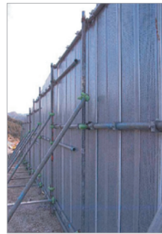
吸音型防音万能板設置状況
